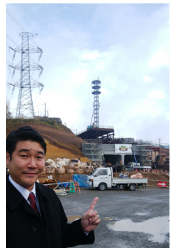
上平尾と小田良を結ぶ新トンネル施工も着々と進む。
