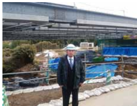
積雪時の三沢川架橋工事視察。坂浜平尾線の孤立問題を解消する重要な橋。
